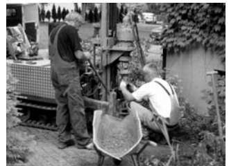
Unser Brunnen wird gebohrt
